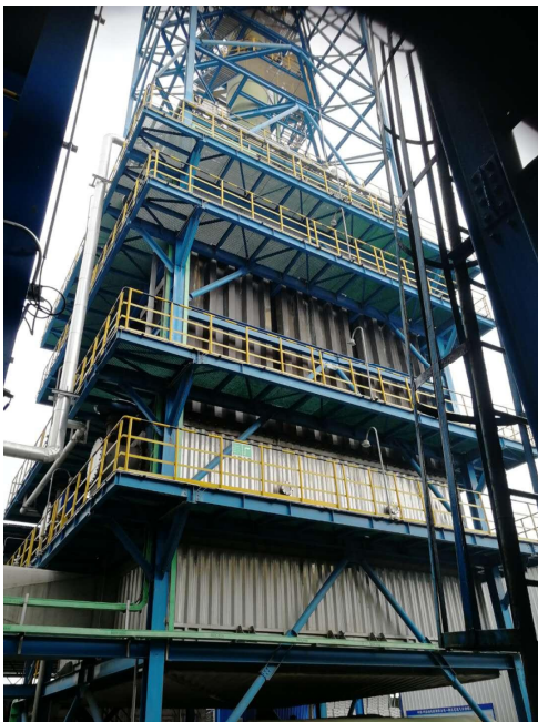
图 3-4 湿式电除尘（雾）器（利旧）
